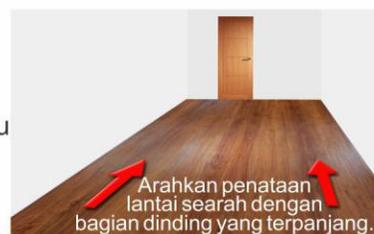
3. Gunakan lem kuning pvc pada permukaan dasar lantai dan bagian bawah dari lembaran Vinyl Floor. Lem merata, diamkan selama 5–10 menit, kemudian rekatkan lembaran dengan dasar lantai. Gunakan palu karet dan roller dari metal untuk memastikan pemasangan yang rapi, tanpa celah sambungan dan rata.
